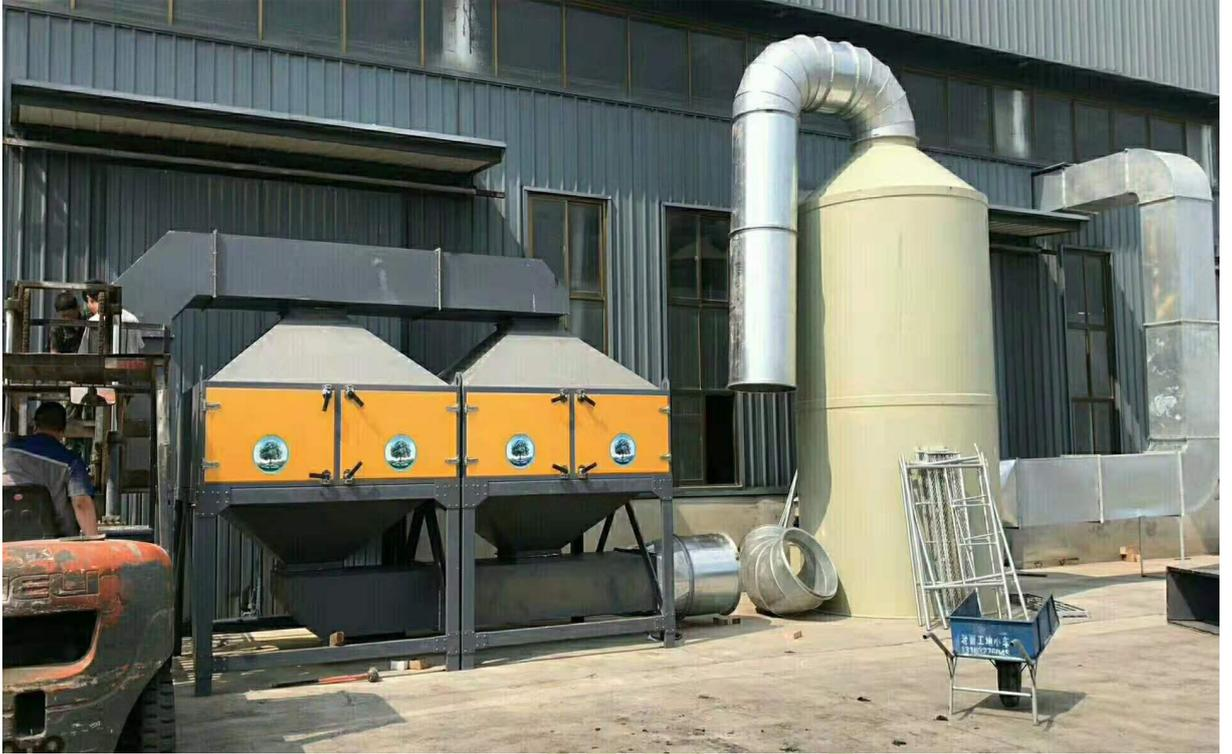
河北沧州方舟橡胶集团有限公司：七套催化燃烧设备（工艺多单元吸附，集中脱附工艺）
